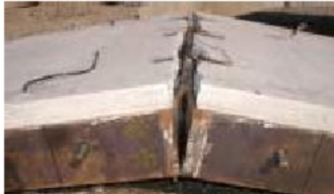
図-5 試験終了後の試験体概況 - 内空側
