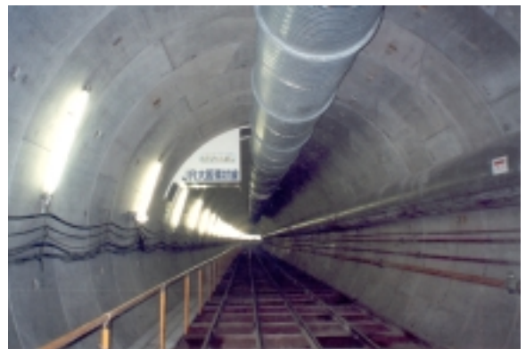
図-6 施工状況写真(JR下付近)
